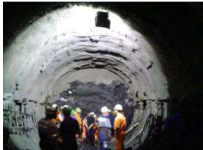
Άποψη του υπογείου μετώπου εκσκαφής
