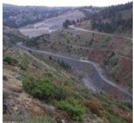
Άποψη του φράγματος, του υπερχειλιστή και τμήματος της λεκάνης κατάκλισης
