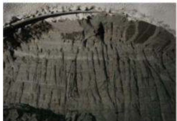
Μέτωπο υπόγειας εκσκαφής – Γκριζα Μάργα
