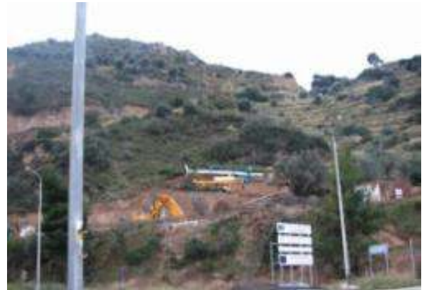
Άποψη στομίου εισόδου σήραγγας Τράπεζας
