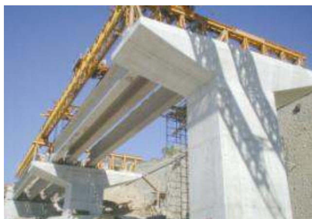
Κατασκευή προεντεταμένων δοκών
