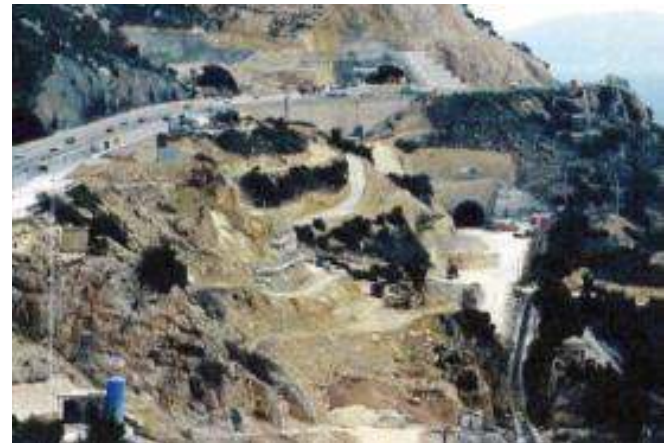
Άποψη του ορύγματος κατά τη φάση διαμόρφωσης
