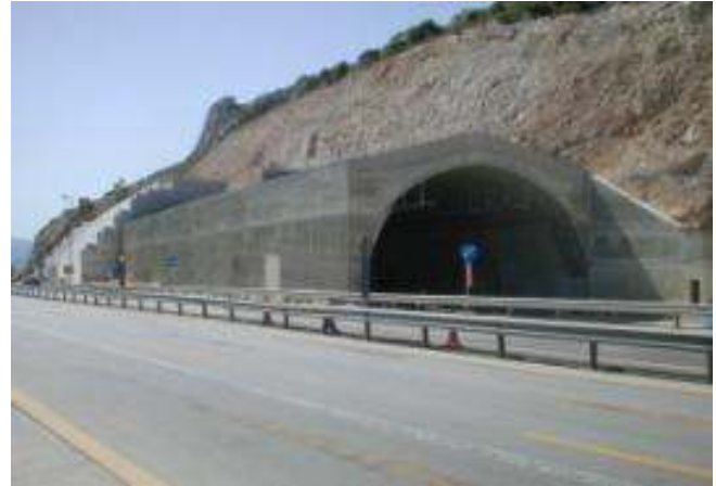
Τεχνικό Cut & Cover στομίου εισόδου σήραγγας ΑΣ1 (Αυτοκινητόδρομος ΠΑΘΕ, τμήμα Κακιά Σκάλα)
