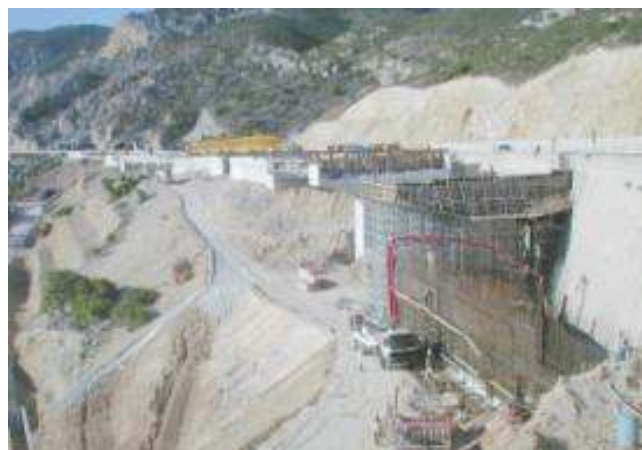
Κατασκευή μεταβατικού φορέα
