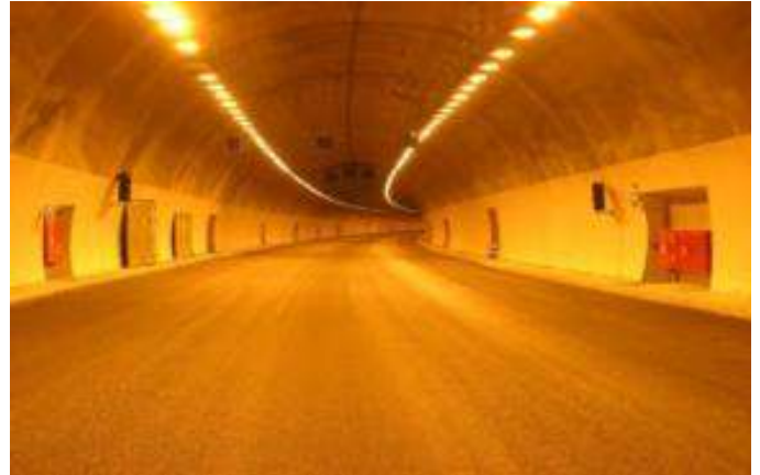
Σήραγγα ΑΣ1 (Γεράνεια)
