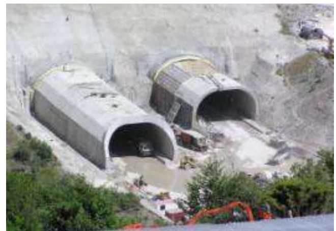
Τεχνικά Cut & Cover στομίων εισόδου σήραγγας Αγ. Νικολάου (Εγνατία Οδός, τμήμα 3.3)
