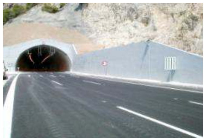
AS3 Tunnel (Ethra)
