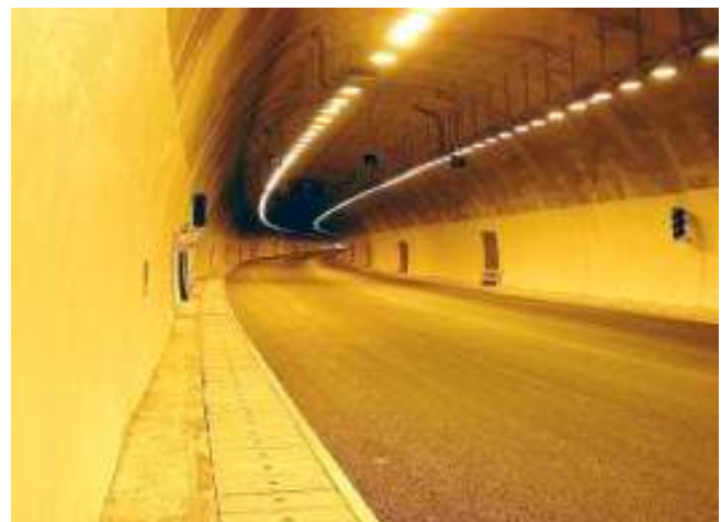
AS2 Tunnel, right bore (Efpalinos)
