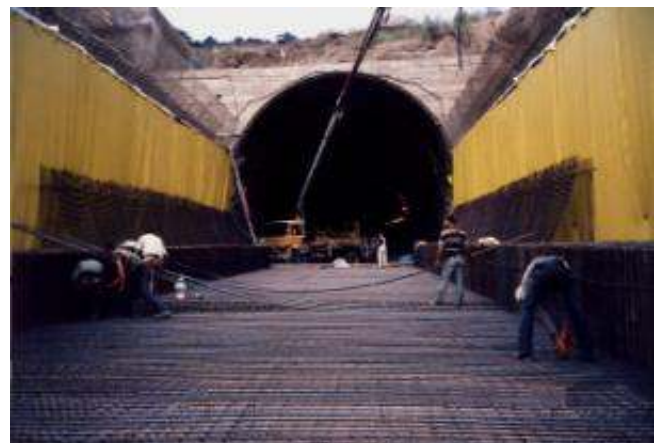
Κατασκευή Cut & Cover στο στόμιο εξόδου
