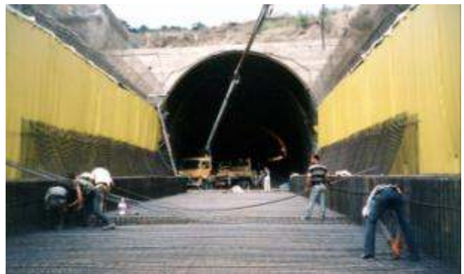
Οπλισμός πυθμένα και κατασκευή πλευρικών τοιχωμάτων
