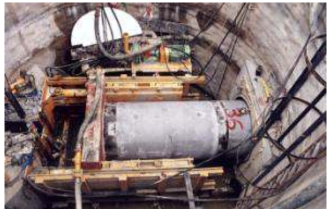
Είσοδος pipe jacking μέσω του φρεάτου για την έναρξη κατασκευής
