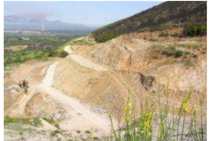
Άποψη περιοχής ορύγματος στην έξοδο της σήραγγας Ραφομάτη
