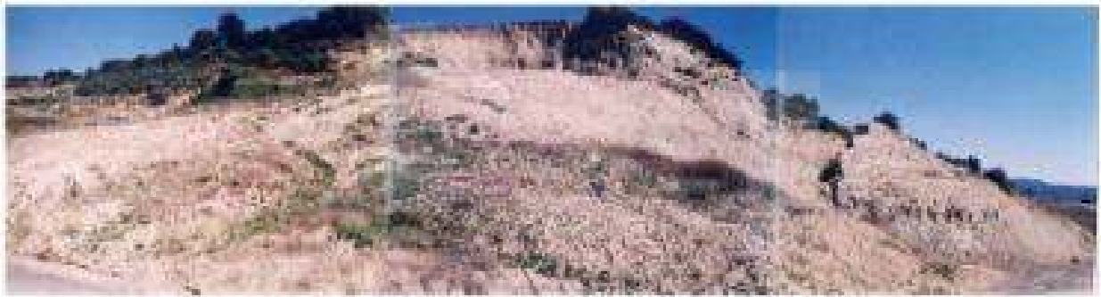
Υφιστάμενη αστοχία πρηνούς με μετακίνηση υλικών εντός το περιτυπώματος της οδού
