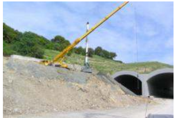
Κατασκευή πασσαλοστοιχίας αντιστήριξης
