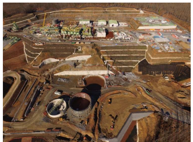
Γενική άποψη εργασιών κατασκευής
