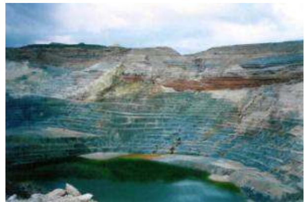
Περιοχή κατολίθησης μετά την αποκατάσταση
