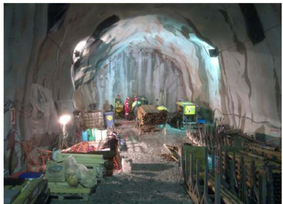
Κατασκευαστικές εργασίες κύριας σήραγγας προσπέλασης
