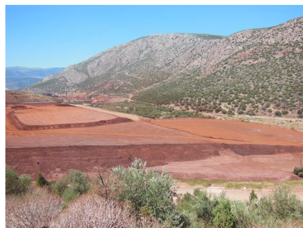
Γενική Άποψη περιοχής έργου
