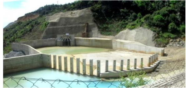
Τεχνικό εισόδου σήραγγας εκτροπής Κοκκινόλακκα
