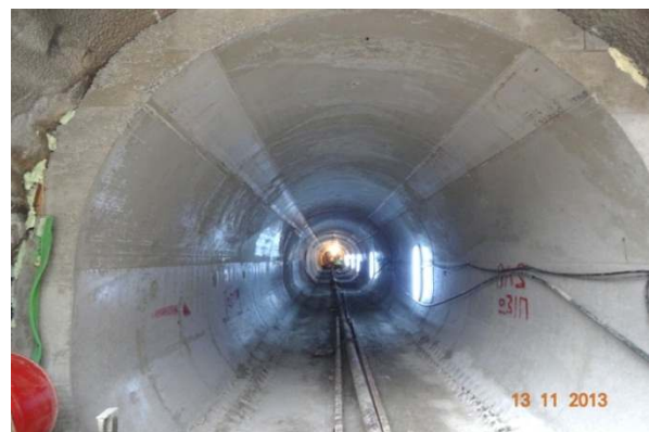
Υπόγειο τμήμα σήραγγας εκτροπής Κοκκινόλακκα
