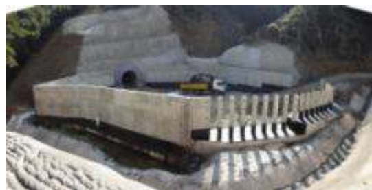
Υδραυλική σήραγγα εκτροπής ρέματος Κοκκινόλακκα & συναφείς εργασίες
