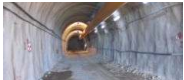
Δευτερεύουσα σήραγγα Ολυμπιάδας
