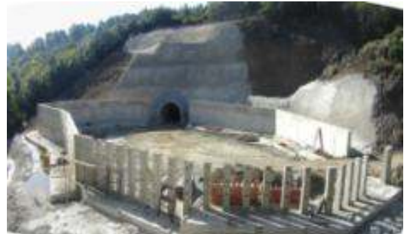
Υδραυλική σήραγγα Κοκκινόλακκα & συναφείς εξωτερικές εργασίες σήραγγας
