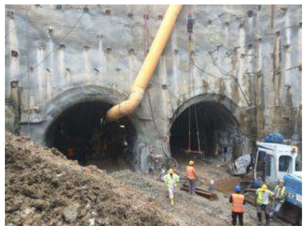
Όρυγμα σταθμού – κατασκευή σιδηροδρόμων NATM για την εγκατάσταση του TBM
