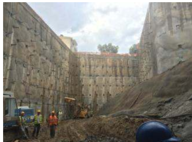
Εργασίες αντιστήριξης στο όρυγμα σταθμού με οπλισμένους πάσσαλους και προεντεταμένα αγκύρια
