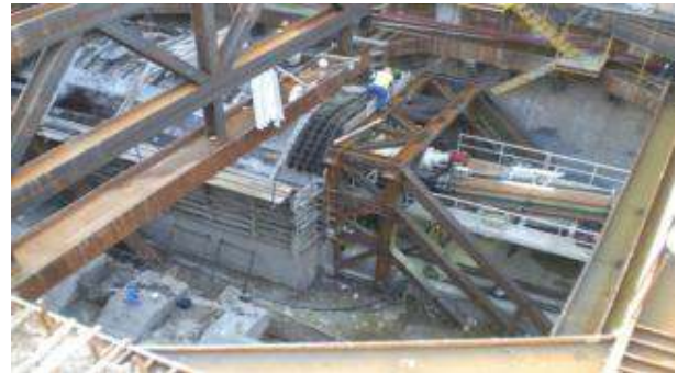
Εργασίες εγκατάστασης TBM – κατασκευή ψευδοσήραγγας
