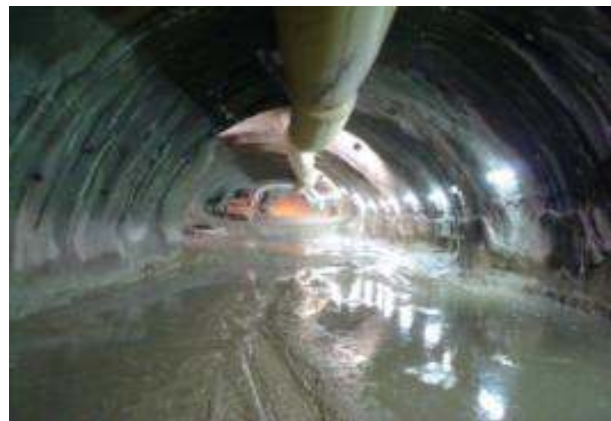
Σιδηροδρομική σήραγγα κατά την α' φάση εκσκαφής
