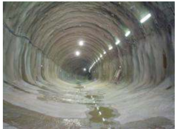
Σιδηροδρομική σήραγγα μετά την πλήρη εκσκαφή
