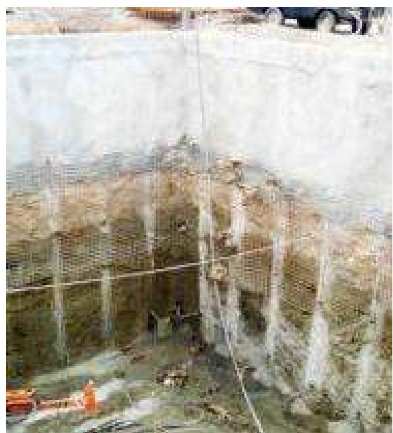
Εργασίες κατασκευής φρέατος
