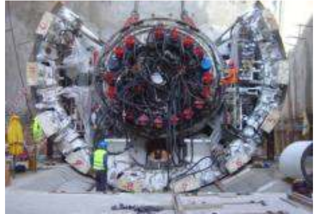
Συναρμολόγηση TBM
