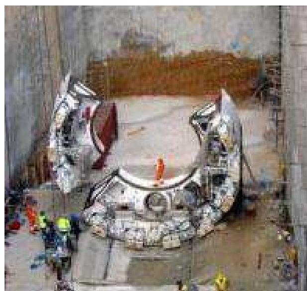
Συναρμολόγηση μηχανήματος TBM
