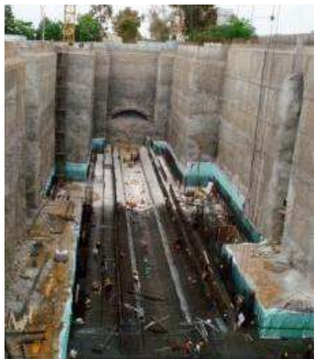
Εργασίες κατασκευής σταθμού
