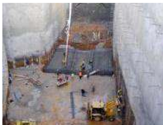
Εργασίες κατασκευής φρέατος
