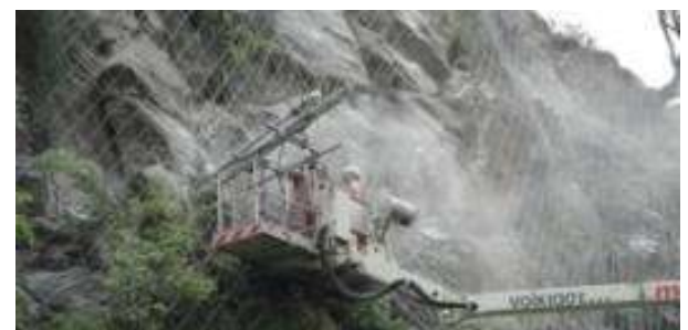
Εγκατάσταση φραχτών προστασίας έναντι βραχοπτώσεων
