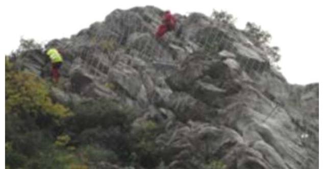
Εφαρμογή συστημάτων σταθεροποίησης πρανούς
