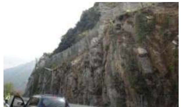
Εγκατάσταση φραχτών προστασίας έναντι βραχοπτώσεων
