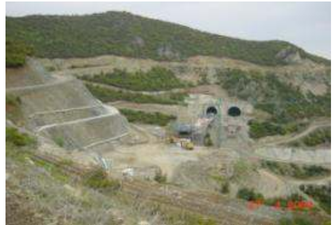
Όρυγμα στην περιοχή θεμελίωσης του ακροβάθρου Α2 της γέφυρας Γ1
