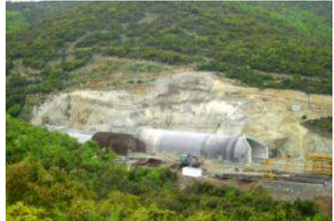
Φορείς Cut & Cover στομίων εισόδου σήραγγας Σ1
