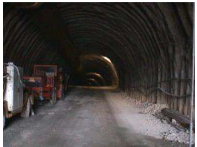
Σήραγγα κατά την α' φάση εκσκαφής
