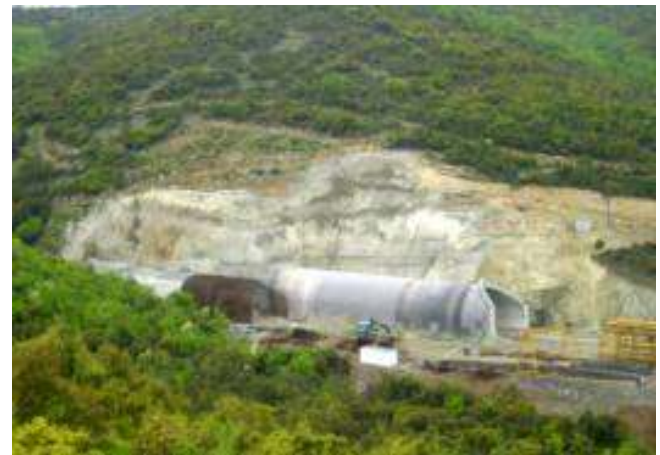
Τεχνικό Cut & Cover στομίου εισόδου σήραγγας Σ1 (Εγνατία Οδός, τμήμα 5.2-5.3)
