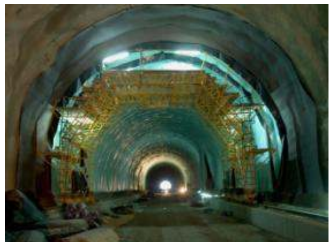
Κατασκευή τελικής επένδυσης στη σήραγγα Σ1
