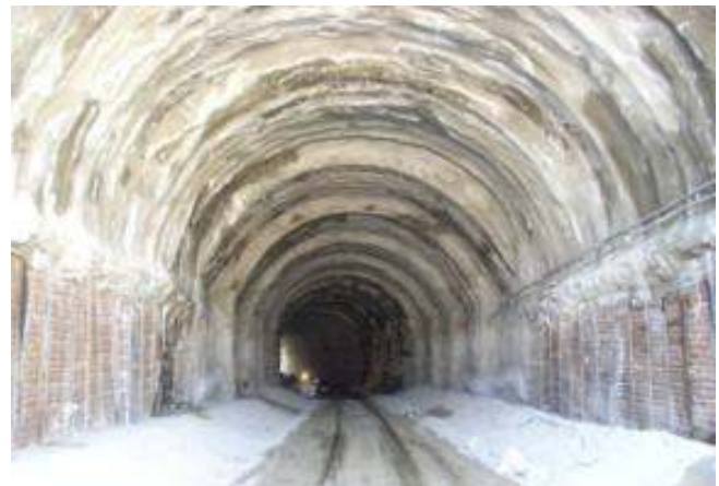
Σήραγγα μετά την πλήρη εκσκαφή
