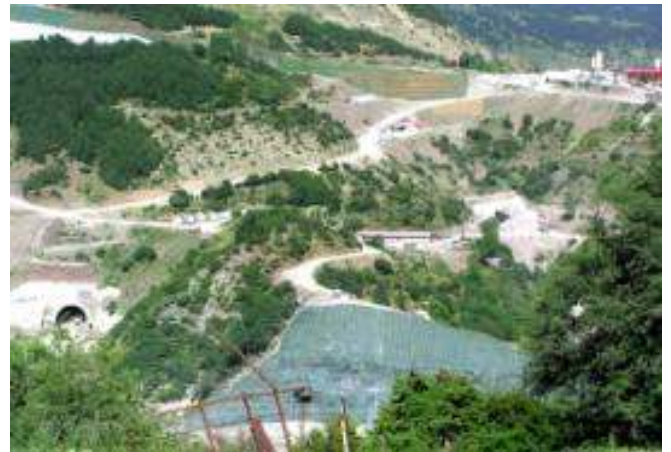
Τοποθέτηση αγκυρίων και ειδικού πλέγματος προστασίας έναντι διάβρωσης
