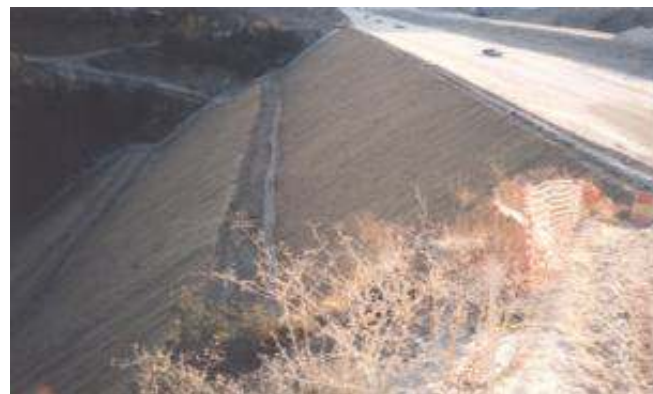
Άοπλο βραχώδες επίκωμα Γ6, μέγιστο ύψος 50m
