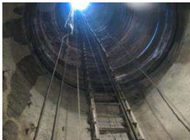
Άποψη του φρέατος εκκαπνισμού
