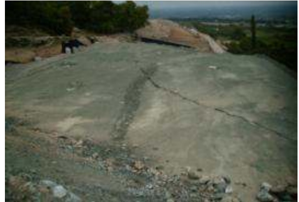
Άποψη της αστοχίας του επικώματος
