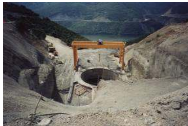
Φρέαρ για τη θεμελίωση του μεσόβαθρου της Γέφυρας Γ1
