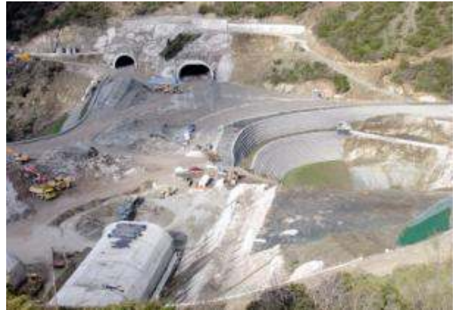
Δυτική άποψη του επιχώματος
