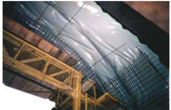
Κατασκευή τελικής επένδυσης
