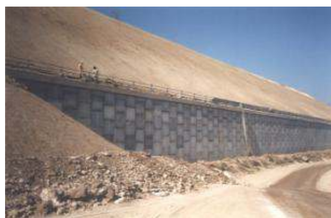
Επίκωμα κατασκευασμένο με τραβερτίνη και οπλισμένο με προκατασκευασμένα στοιχεία, μέγιστο ύψος 38m
