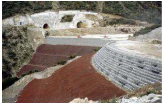
Οπλισμένη γη στην ανώτερη υψομετρικά βαθμίδα
