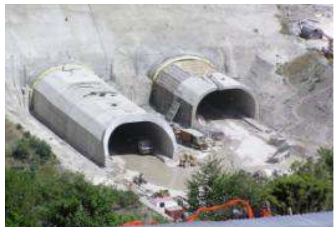
Φορείς Cut & Cover στομών εισόδου
