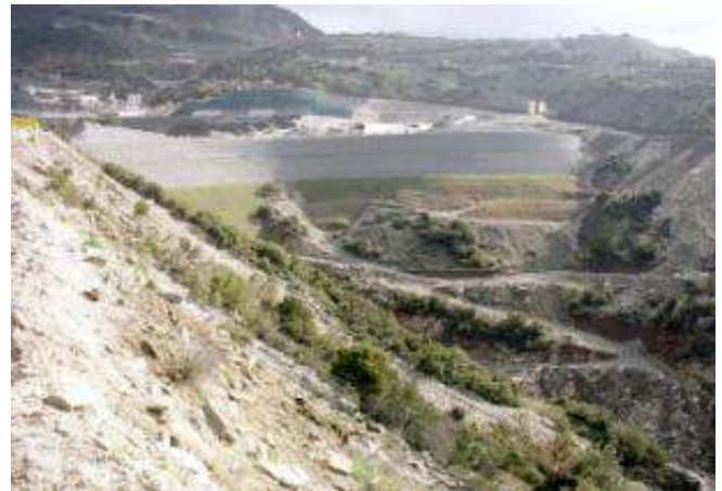
Νότια άποψη του επιχώματος
