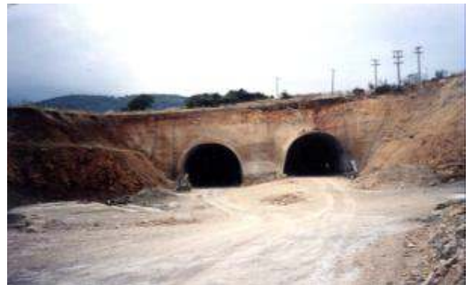
Εργασίες τελικής αποκατάστασης στομίων εισόδου
