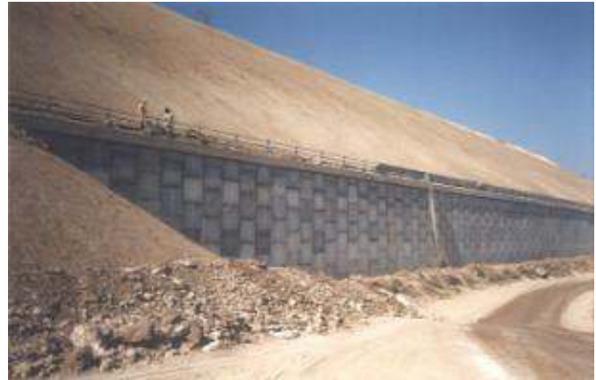
Αποψη του επίχωματος κατά τη φάση κατασκευής
