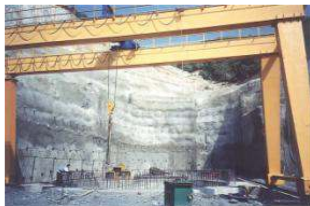
Έργα αντιστήριξης για την κατασκευή του φρέατος θεμελίωσης του κεντρικού μεσόβαθρου
