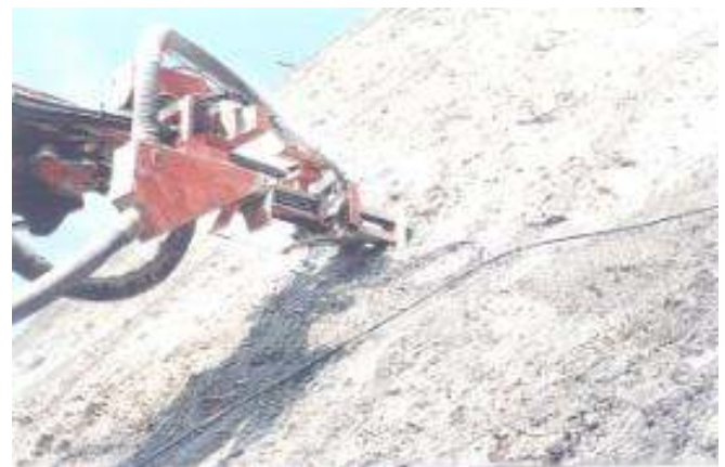
Εργασίες εφαρμογής πλέγματος τύπου TECCO της Geobrugg
