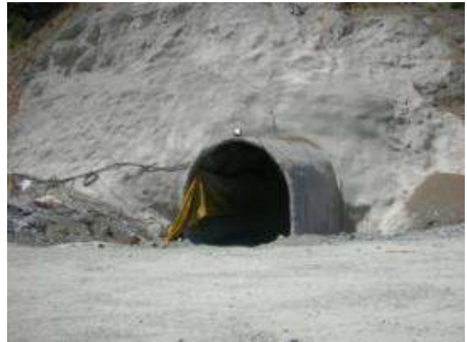
Στόμιο εισόδου σήραγγας αποστράγγισης
