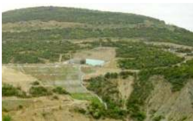
Άποψη του επικώματος προς τα κατόντη μετά την ολοκλήρωση των εργασιών
