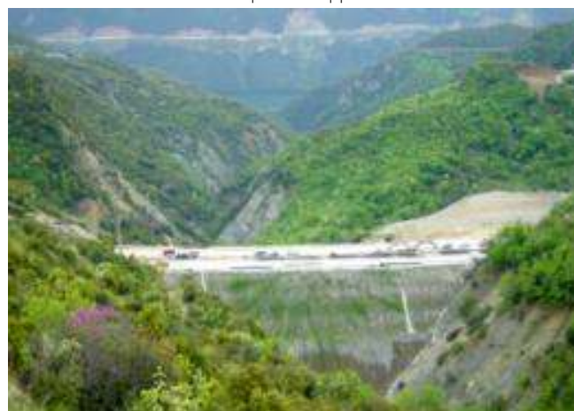
Άποψη του επικώματος προς τα ανάντη μετά την ολοκλήρωση των εργασιών
