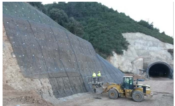
Υψηλό όρυγμα με χρήση μόνιμων αγκυριών ολόσωμης πάκτωσης και κατάλληλη προστασία των πρανών με αγκυρωμένο συρματοπλέγμα
