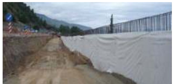
Κατασκευή επικώματος όπισθεν του τοίχου αντιστήριξης
