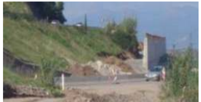
Γενική άποψη τοίχου αντιστήριξης ποδός επικώματος
