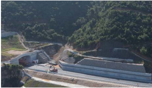
Σύστημα αντιστήριξης με πασσαλότοιχο και επιφανειακή προστασία με συμματοκιβώτια
