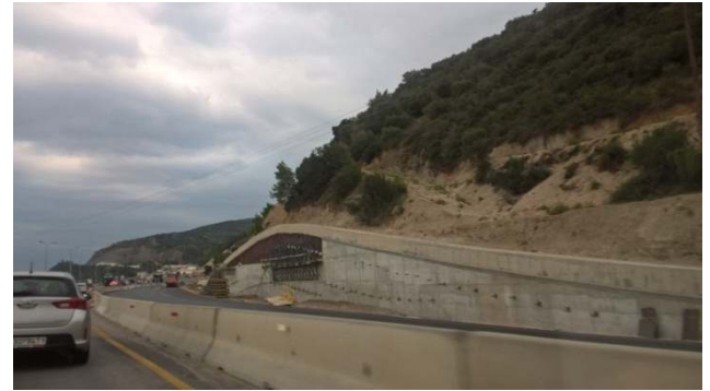
Σύστημα αντιστήριξης πασσαλότοιχου με προεντεταμένα αγκύρια
