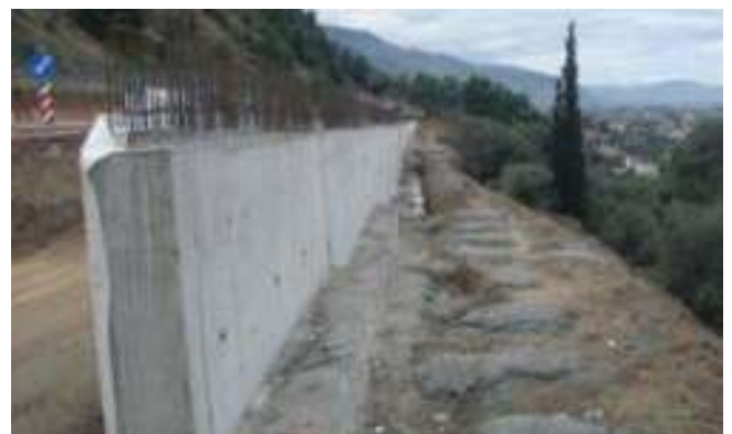
Κατασκευή τοίχου αντιστήριξης
