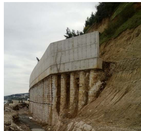
Σύνθετο σύστημα αντιστήριξης με προεντεταμένα αγκύρια
