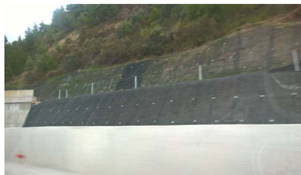
Όρυγμα με χρήση μόνιμων αγκυριών ολόσωμης πάκτωσης και κατάλληλη προστασία των πρανών με αγκυρωμένο συρματοπλέγμα και τοίχος αναχαίτισης βραχοπτώσεων
