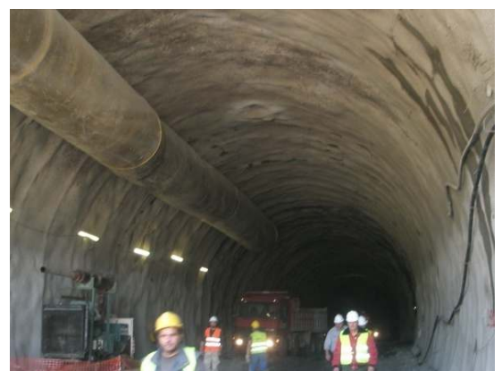
Μέτωπο εκσκαφής της σήραγγας και υπόγειο τμήμα με τα προσωρινά μέτρα υποστήριξης
