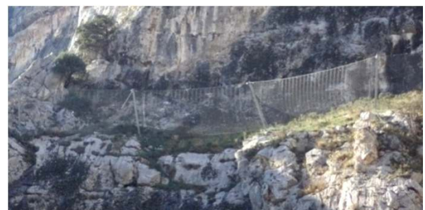
Μέτρα προστασίας έναντι βραχοπτώσεων στο βόρειο δεξιό στόμιο της σήραγγας
