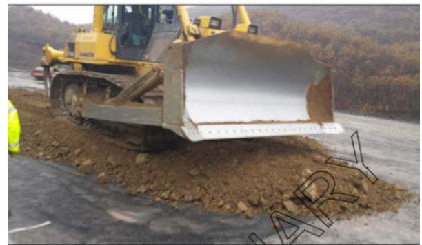
Τοποθέτηση και συμπίκνωση υλικού επίχωσης
