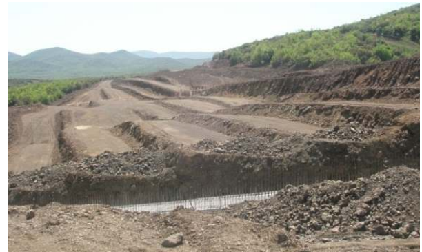
Διαμόρφωση αναβαθμών αγκύρωσης επιχώματος
