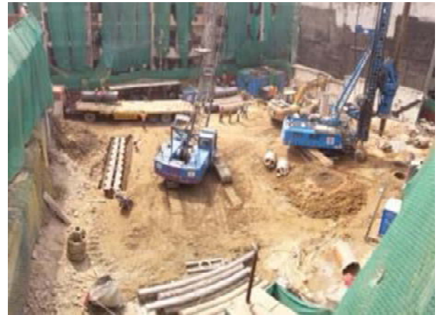
Φρέαρ αποσυναρμολόγησης – Κατασκευή Πασσάλων
