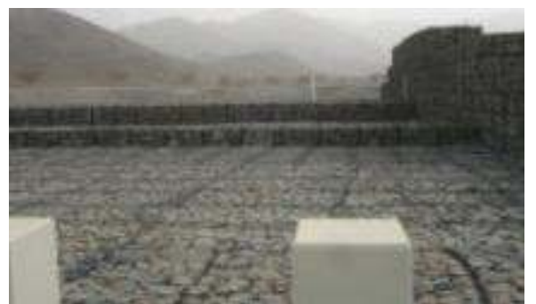
Άποψη φράγματος με συρματοκιβώτια
