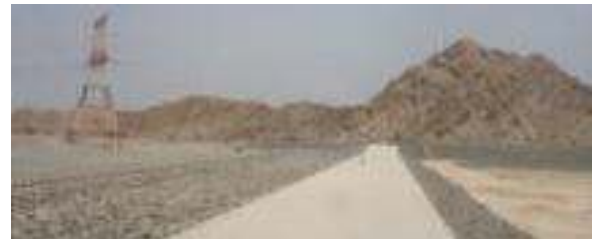
Άποψη του υφιστάμενου φράγματος Ham στη Fujairah
