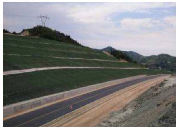
Κατασκευασμένα τμήματα του ανοικτού ορύγματος αυτοκινητοδρόμου
